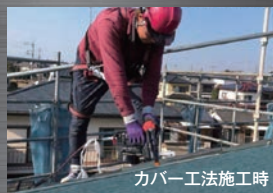
カバー工法施工時
